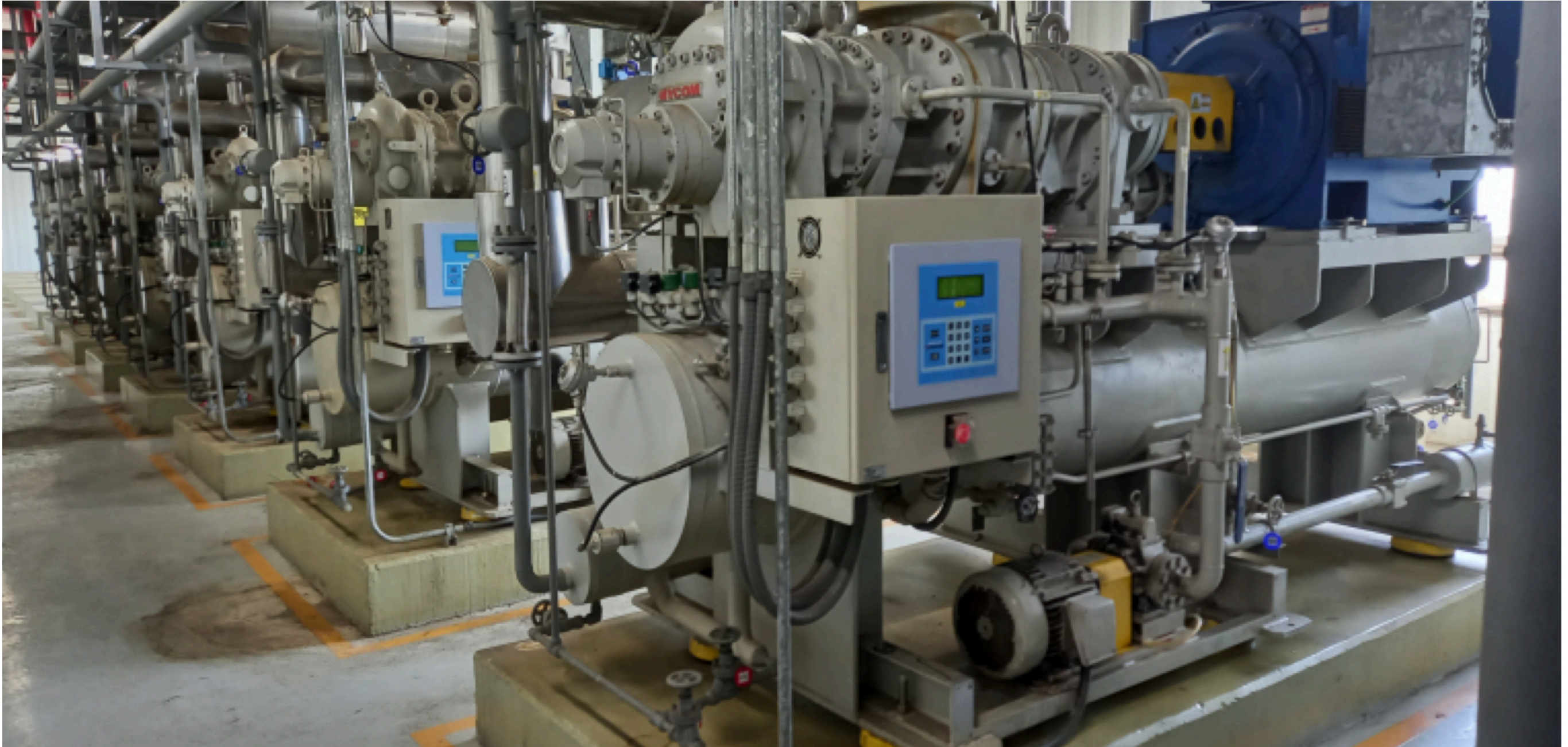
[그림 3-1] 암모니아 냉동기 현장사진
