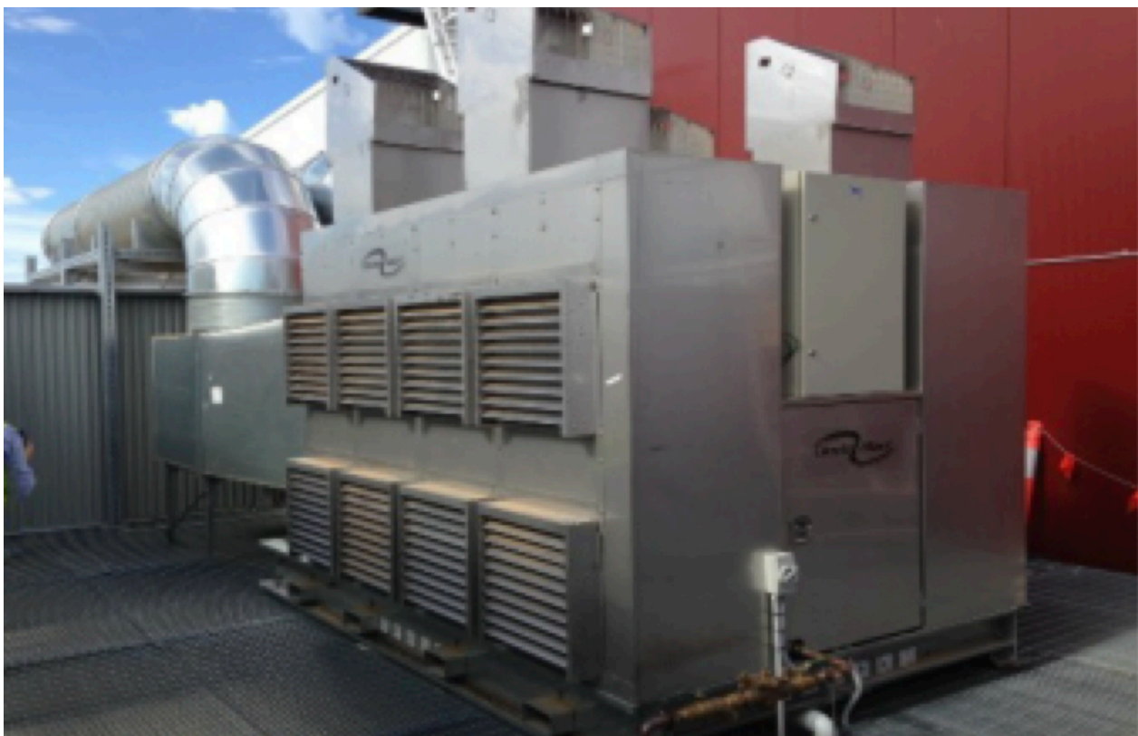
00마트 예냉용 간접증발냉각장치 (CW-80모델) 설치사진
