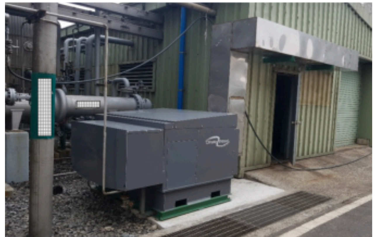
00공장 예냉용 간접증발냉각장치 (CW-H15모델) 설치사진
