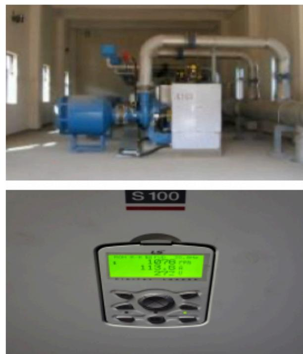
[图5-3]改善后Blower系统图(控制转数)
