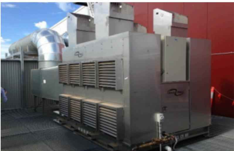
00超市预冷间接蒸发冷却器
