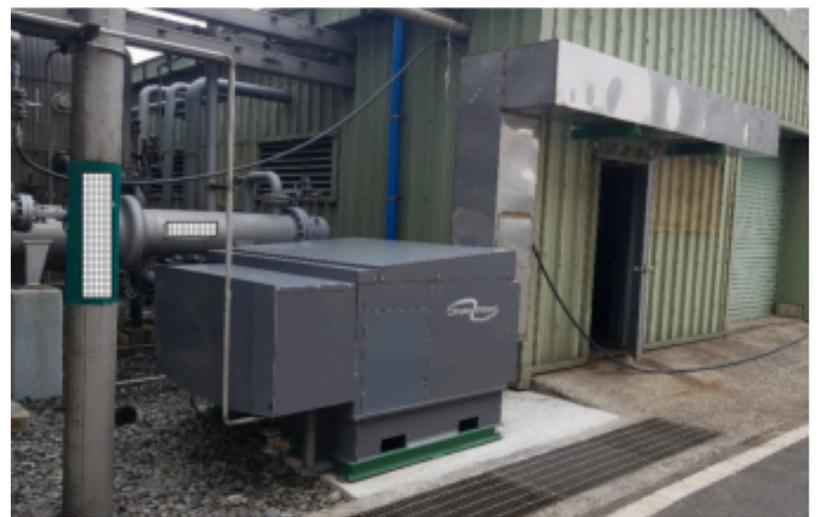
00工厂预冷间接蒸发冷却器
