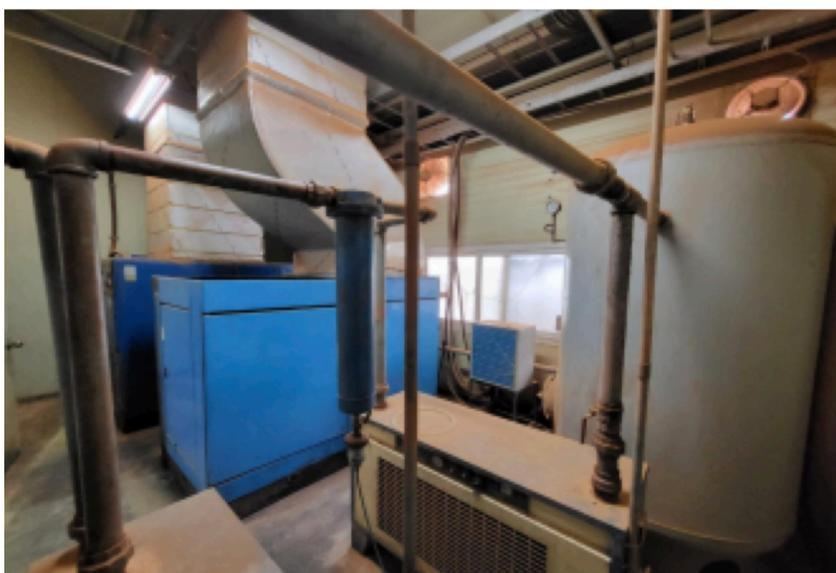
[照片2-1]空气压缩机照片
